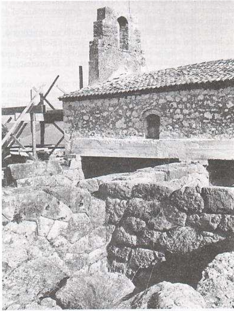
Con un techo de cemento armado, el profesor Sotiris Dakaris salvó la iglesia bizantina que se encontraba encima del oráculo.
